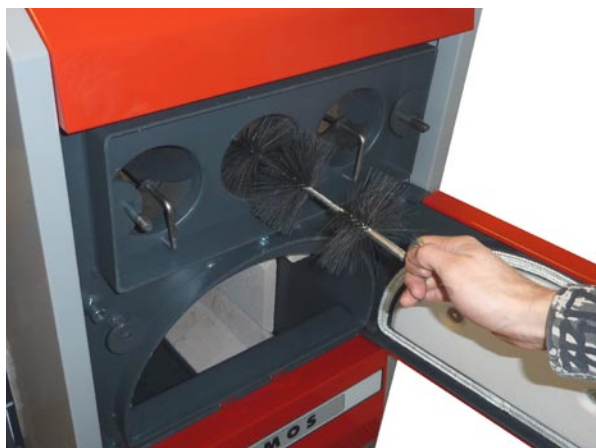
Vyčištění výměníku (trubkovnic) vloženým kartáčem (u kotle D20P, D30P, D40P a D45P)
