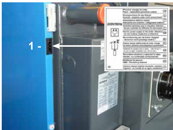
Konektor v pravé kapotě kotle
