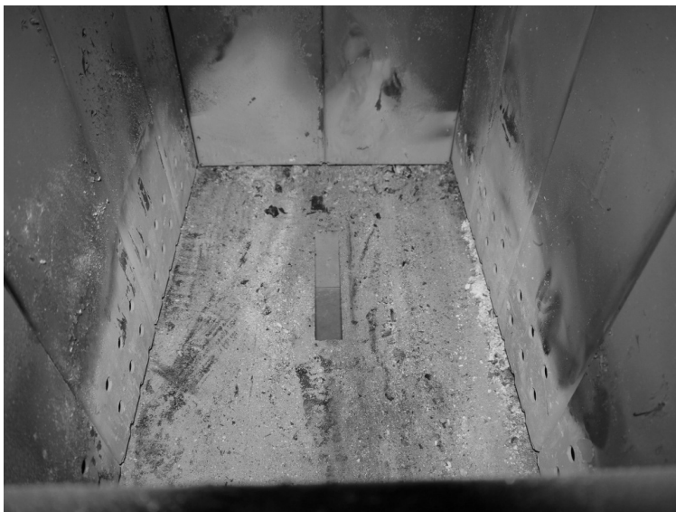
Obr. 6 Správně vyčištěná nakládací komora
