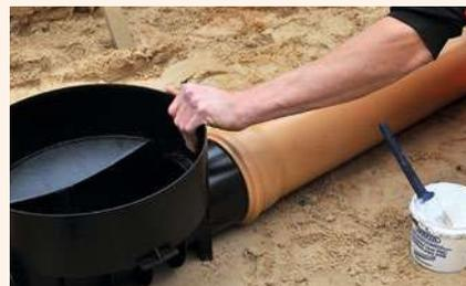
Při provádění hrdlových spojení změřte hloubku hrdla a stanovte nutnou hloubku ke vsunutí dířku potrubí.
