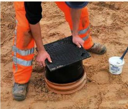
Teleskopickou trubku s poklopem vložte do vlnité roury a několikrát posuňte, aby se mazivo rozneslo po co největší ploše. Takto usazený poklop s teleskopem nastavte do požadované výšky.
