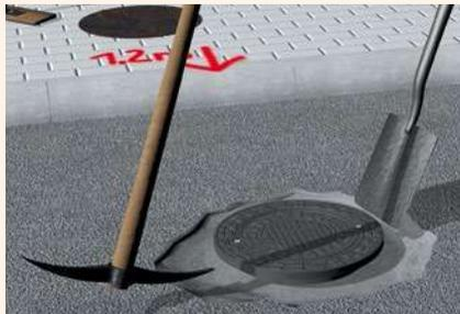
Odkryjte poklop, sejměte plech a pomocí vhodného nářadí – krumpáče nebo lopaty vysuňte poklop nahoru. Vzniklé mezery po vysunutí zasypejte, pečlivě vyplňte prostory pod poklopem namontovaným na teleskopické rouře. Poblíž poklopu proveďte zhutnění vibrační deskou („žábou“).
