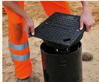
Litínový poklop nasadte do teleskopické roury. Tři výřezy v poklopu musí být vyrovnány tak, aby mohl zaklapnout.
