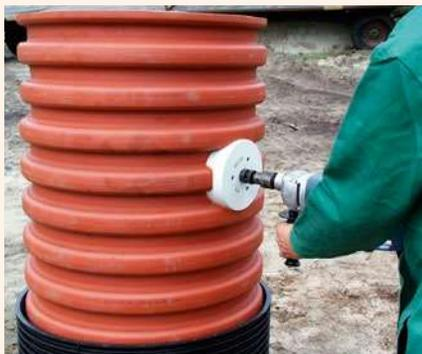
Speciálním vrtákem se vyvrtá otvor ve vlnité rouře.
