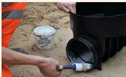
Očistěte a namažte těsnění v hrdle.
