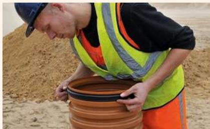
Očistěte zkrácenou šachtovou rouru od odřezků vzniklých při řezání. Nasadte čisté těsnění do první prohlubně vlnité roury. **Těsnění nesmí být po nasazení zkroucené.**
