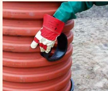
Vloží se těsnění spojky IN-SITU.
