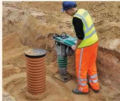
Vyplňte výkop vrstvami o výšce max. 30 cm, šachtu obsypejte rovnoměrně po celém obvodu. **Stupeň zhutnění zeminy by měl odpovídat půdním podmínkám a budoucímu zatížení (min. 92 % SP v zeleném terénu bez spodní vody, 95 % ve zvodnělých půdách a min. 98 % pro komunikace s vysokým dopravním zatížením).**
