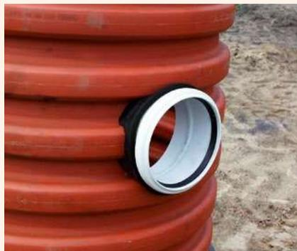
Vnitřek instalovaného těsnění se maže kluzným prostředkem, což umožňuje vsunutí potrubí.
