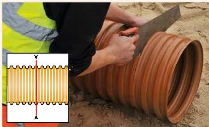
Vlnitou šachtovou rouru zkraťte na požadovanou délku. Řežte středem vystupující vlny. **Šachtová roura může být zkrácena na požadovanou délku rovněž po zasypání výkopu.**
