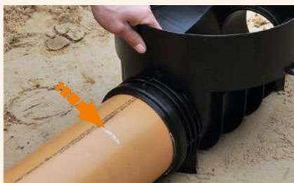
Zasuňte očištěný dířek potrubí do hrdla po vyznačené místo.
