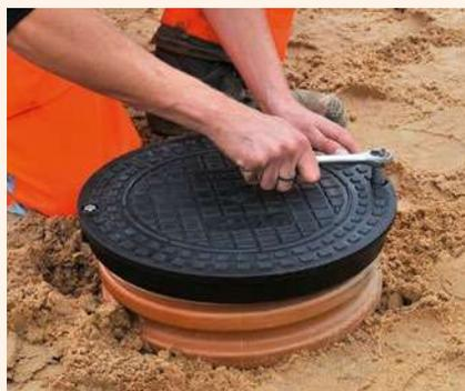
Po nasazení poklop sešroubujte s šachtovou rourou šestihřannými šrouby. Poklop se přitom na šachtovou rouru přitiskne nebo zafixuje.
