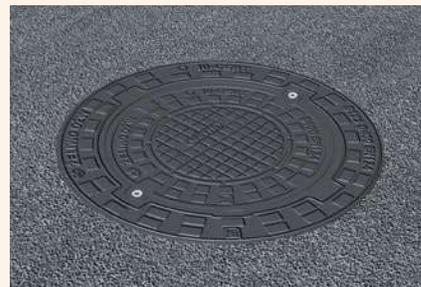
Po ukončení prací z poklopu odstraňte zbytky asfaltu.
