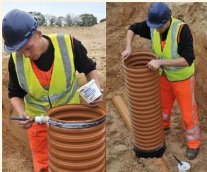
Namažte těsnění na šachtové rouře a vtlačte rouru do hrdla šachtového dna.
