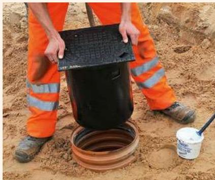
Teleskopická roura se eventuálně očistí a potřese rovnoměrně po obvodu kluzným přípravkem. Podle potřeby je možné rouru zkrátit. Pak musí být začištěna a znovu zkosena. **Při zkracování teleskopické roury je třeba mít na paměti minimální zásuvnou hloubku 100 mm do šachtové roury.**
