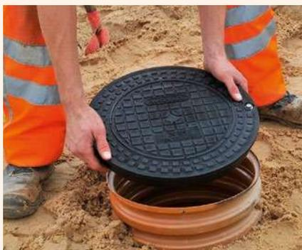
Vnější šestihřanné šrouby (M8) poklopu nejprve uvolněte klíčem s vnitřním šestihřanem (13 mm) tak, aby bylo možné poklop nasadit na konec šachtové roury.
