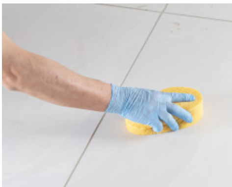
Čištění a konečná úprava spár tvrdou houbou z celulózy
