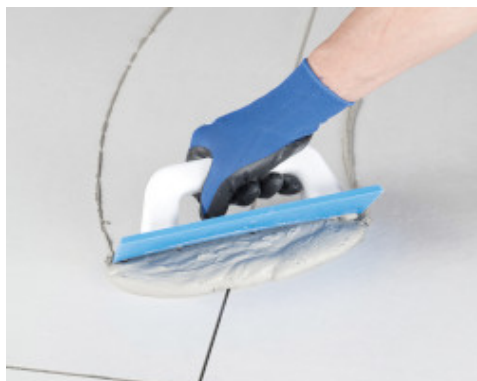
Nanášení Ultracoloru Plus gumovou stěrkou
