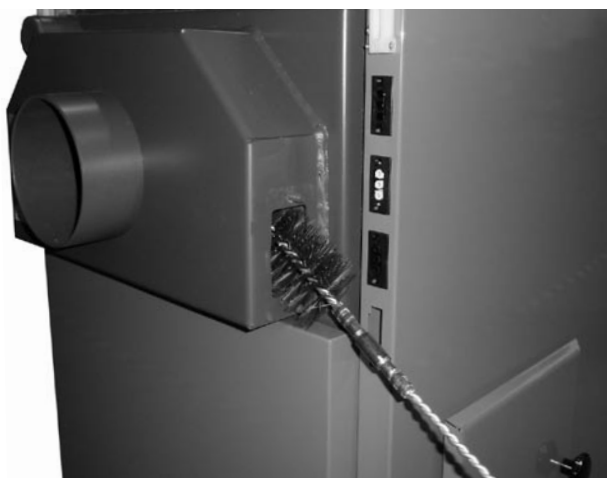
Ukázka čištění kouřového kanálu. Provádíme po vyčištění trubkovnice ve spalovací komoře kotle
