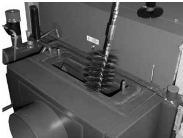
Ukázka čištění kouřového kanálu drátěným kartáčem.
