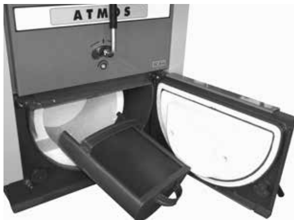
Otevřený spodní prostor kotle s kulovým prostorem s ukázkou vybírání popela pomocí popelníku
