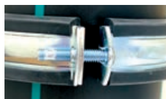
Způsob utažení horní posuvné objímky
