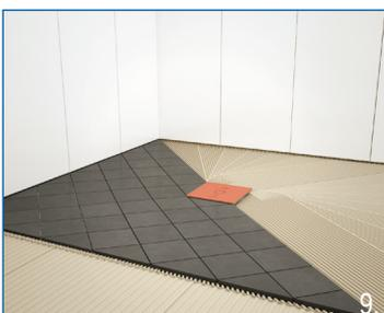
DE Aufsatzrahmen durch Drehen an das Fliesenbild anpassen (360° drehbar), Fliesen verlegen.
