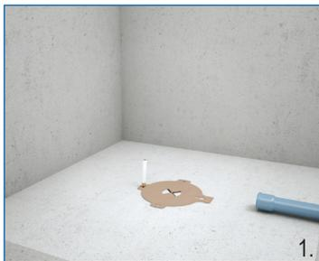
DE Ablaufposition festlegen, Montageschablone in Richtung Abflussrohr auflegen und Löcher für die Bohrungen markieren.
