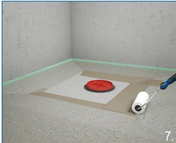
DE Feuchtigkeitsabdichtung im gesamten Duschbereich sowie unter und ober der Dichtmanschette auftragen (Sandwichverfahren), alle Anschlüssen mit beiseitigen Dichtbändern versehen.
