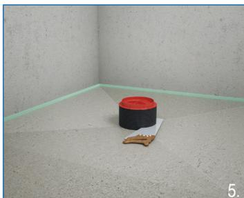
DE Nach dem Aushärten des Estrichs den herausstehenden Rohrstutzen estrichbündig mit einer Säge abschneiden.
