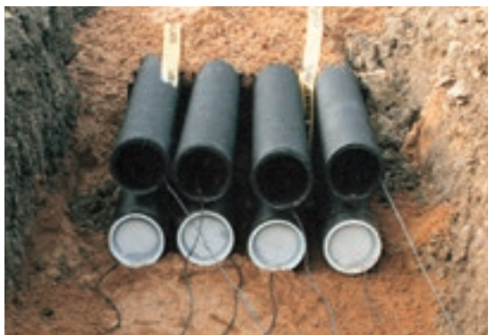
Kabuflex S – distanční rozpěrky určující směr umožňují bezpečnou a rychlou pokládku
