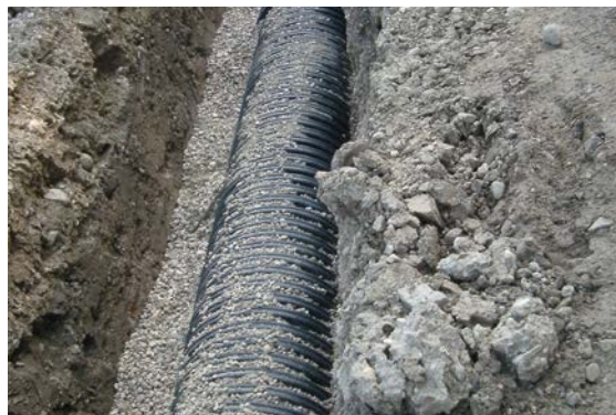
Obr. 07-3 Potrubí RAUPIPEX ve výkopu
