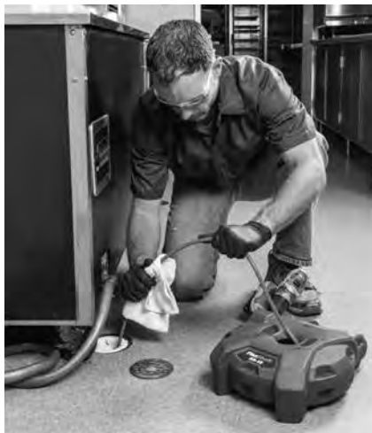
Obrázek 15 – Aplikace maziva na kabelové pouzdro
