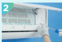
Odstraňte šroub na ovládací skříňce
